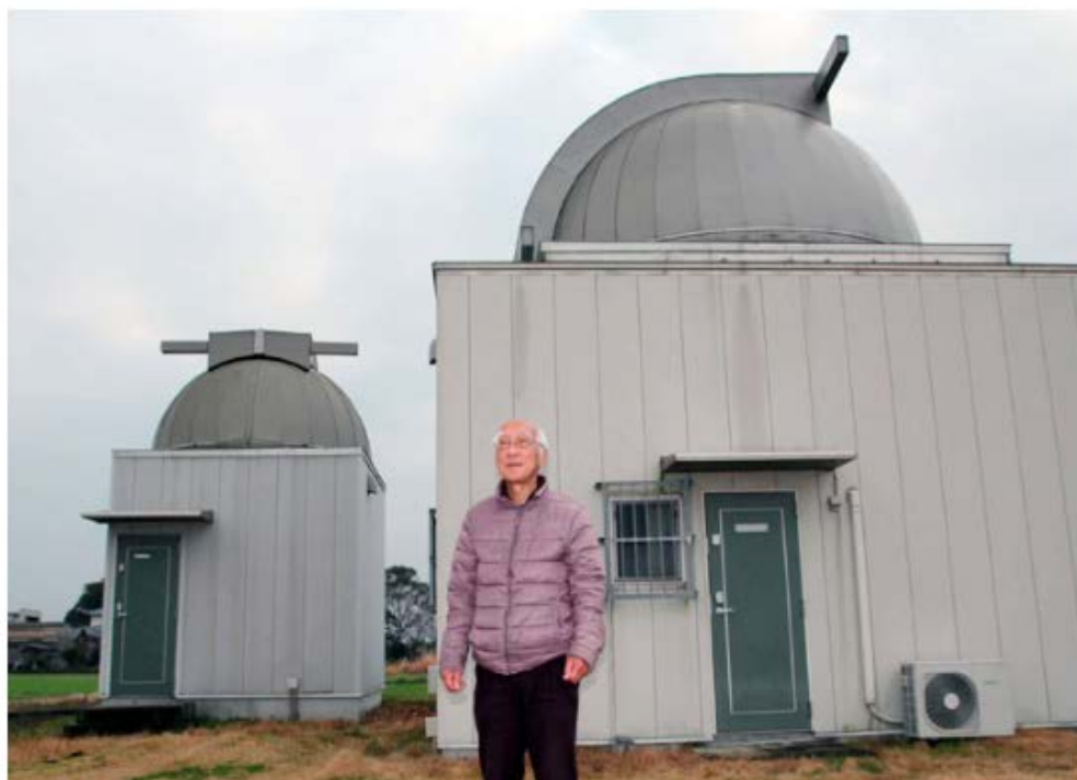
栢島さんと私設天文台「みやきアルゲンテウス」。アルゲンテウス（Argenteus）はラテン語で「銀」を表し、シルバー世代をもじったジョークだ。天体力学の大家、古川麒一郎さん（2016年没）が命名された。それぞれのドームに口径40cm F3.3ペーカースシュミットと、口径51cm F6.7リッチークレチアン望遠鏡が格納されている
